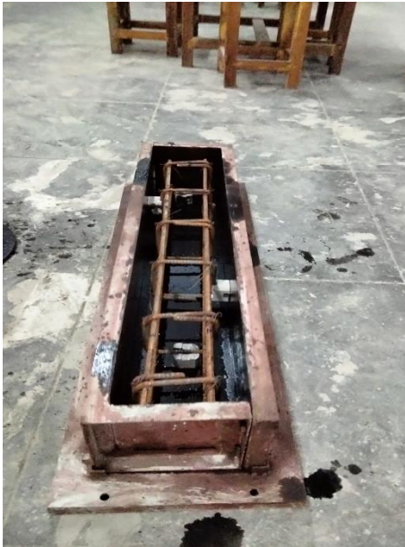
Fig:2 Beam Mould
